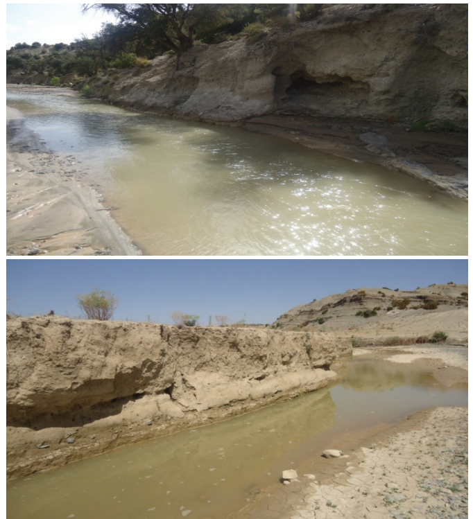
Figure 3: Berges sapées en amont du cours d'eau El Abid
